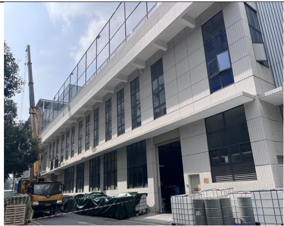
项目北面工业厂房
