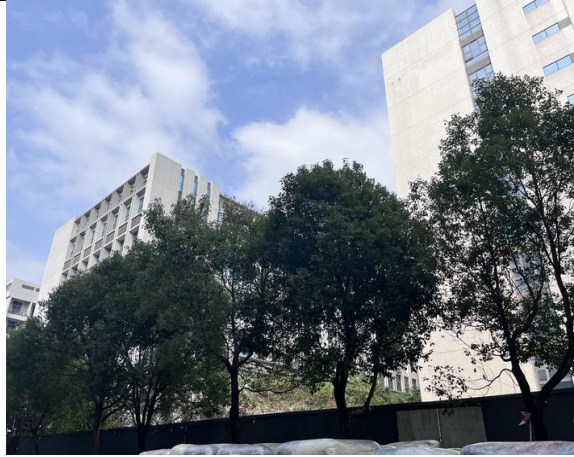
项目东面工业厂房
